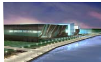
Торговый комплекс «Аврора»
