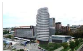
Офисный центр «Стальсеть»
