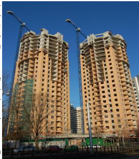
Текущий этап строительства ЖК «Ривьера»
