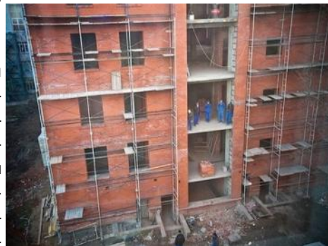
Объект незаконного строительства в районе ул. Маяковского
